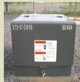
Las otras dos posibilidades son más simples, simplemente se basan en la capacidad de la subestación o del Generador que alimenta la instalación, multiplicando los kVA por el factor de potencia de 0.9 para encontrar los kW de capacidad instalada de la instalación.
