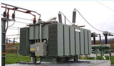
La cromatografía es una técnica de análisis de gas, capaz de procesar pequeñas muestras con gran exactitud, estableciéndose como un instrumento eficaz y de bajo costo, para la identificación de una falla incipiente. Permitiendo proyectar con antelación la salida de servicio de una unidad para revisión interna y evitar una falla insospechada del transformador.
